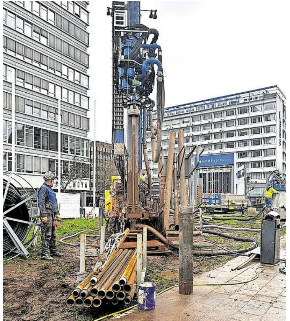
Mit dieser Maschine wurden insgesamt 27 Bohrungen für die Erdwärme-Sonden durchgeführt. Foto: CCS
