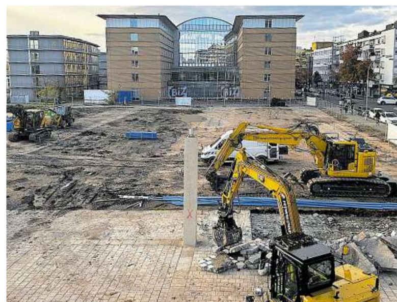
Auf der Baustelle direkt neben der Congresshalle in Saarbrücken schreiten die Arbeiten planmäßig voran.
