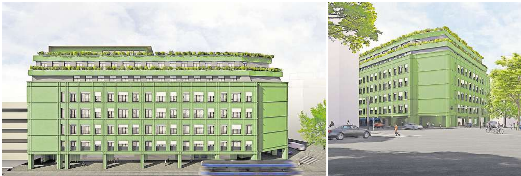
Das Bestandsgebäude Ecke Kaiserstraße/Viktoriastraße wird umfassend modernisiert und um zwei Geschosse erweitert. In Victor's Residenz Saarbrücken bleiben Senioren selbstbestimmt und „mitten im Leben“.
