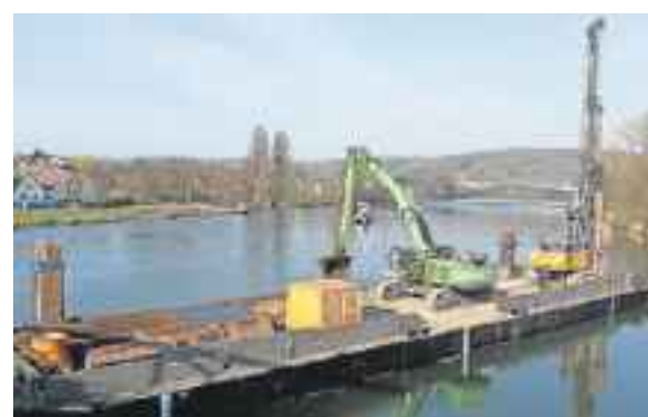
Bohrung von einem Ponton aus in Eltmann am Main.
